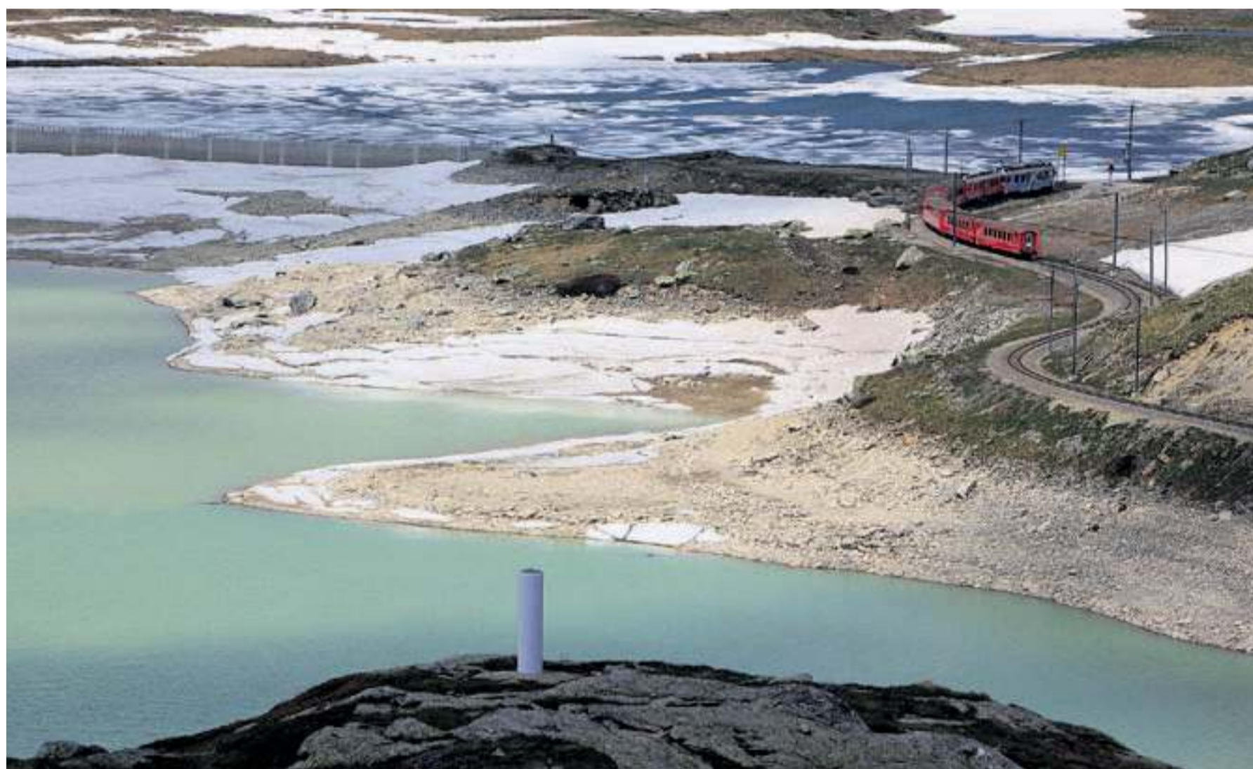
Der Lago Bianco (Bild) bleibt zumindest bis 2019, wie er ist: Das Trasse der Berninabahn muss nicht wegen der geplanten Erhöhung der Staumauern verlegt werden. Bild: key
